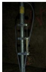
Capteur de déplacement vertical pour annoncer la rupture d'un pilier
