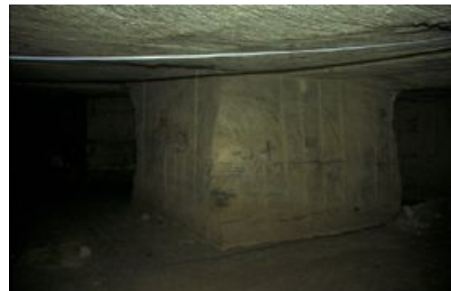
Pilier soutenant la voûte d'une carrière souterraine
