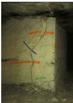
rupture d'un pilier
